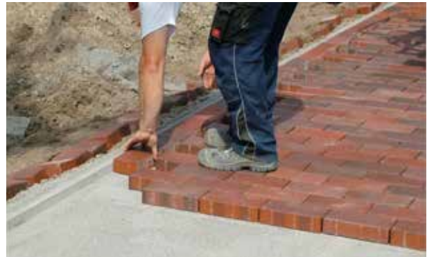
Abb. 5-11: Handverlegung von Pflasterklinkern
