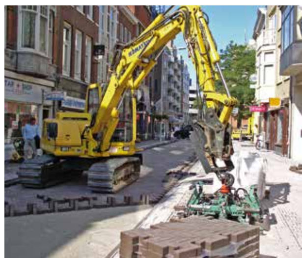
Maschinenverlegung von Pflasterklinker, Den Haag, Niederlande
