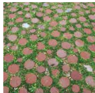
Pflasterfuge - gebunden mit Fugenmörtel und umweltstoffen als begrünte Fuge
