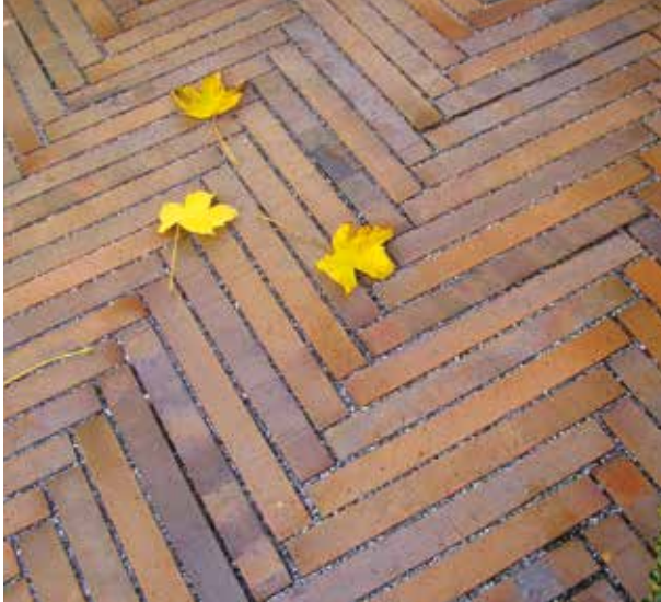
Pflasterklinker als Langformat verlegt im Fischgrätverband
