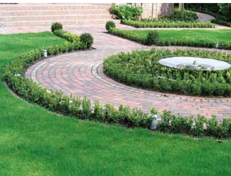
Abb. A5-9: Mit Rechteckklinkern verlegter Bogen. Die Rand- und Passsteine müssen passend zugeschnitten werden
