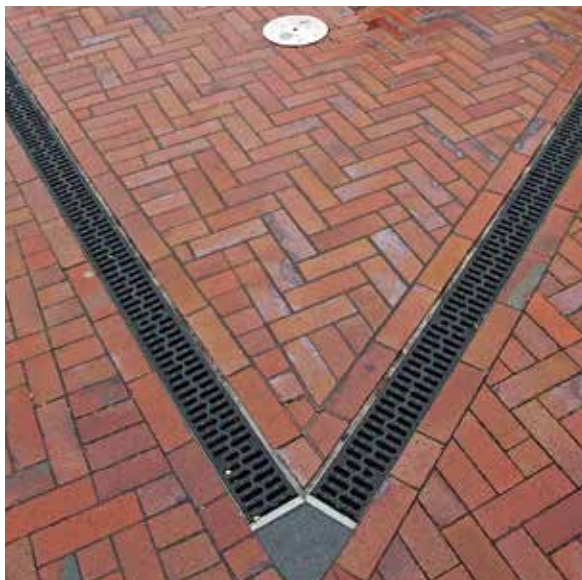
Abschlussdetail – Entwässerungsrinne, Barsinghausen, Deutschland
