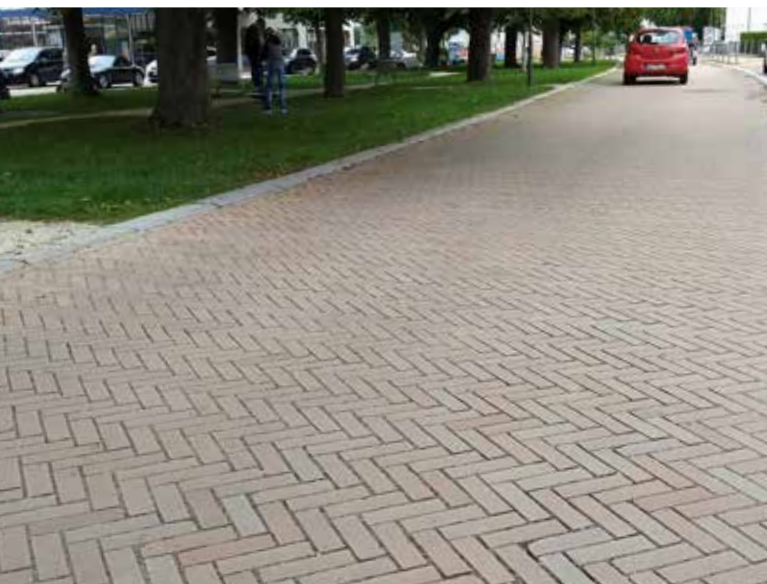
Rechtecksteine diagonal zur Fahrtrichtung wirken geräuschmindernd
